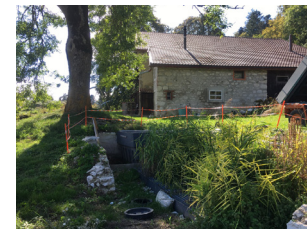
Habitation dans le Jura (NE)
